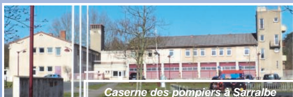
Caserne des pompiers à Sarralbe
